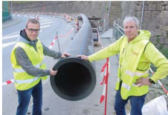
Adrien Fournier (à g.) et Jean-Claude Cretton sur le chantier de Sinergy.
